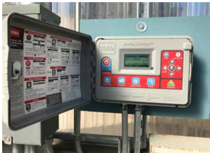
FIGURA 22. Controlador de riego típico de bajo costo, capaz de controlar múltiples horarios programados para satisfacer las diferentes necesidades del cultivo. Foto: Christof Bernau
